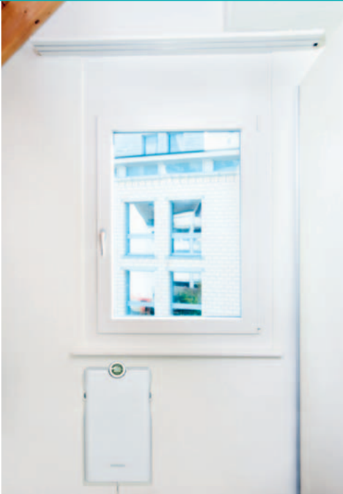
Montagebeispiel Schalldämmlüfter
